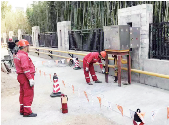
维保工人在现场紧急抢修。
