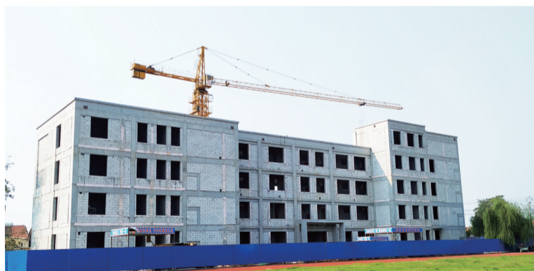
新建华沟小学教学楼。
