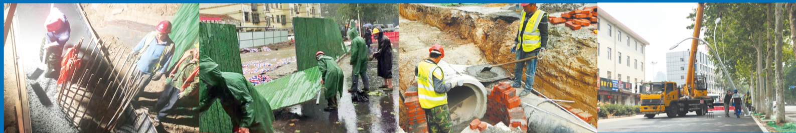
昼夜施工保进度
