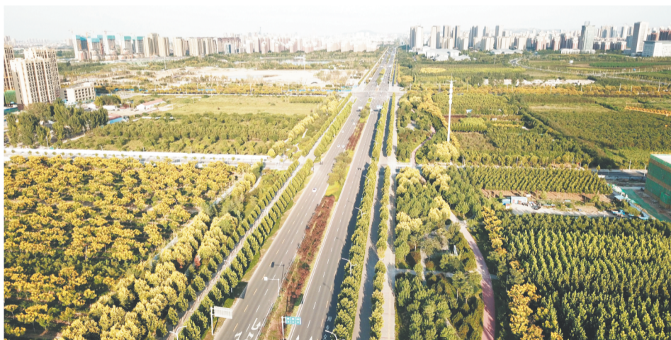
中润大道西延工程
