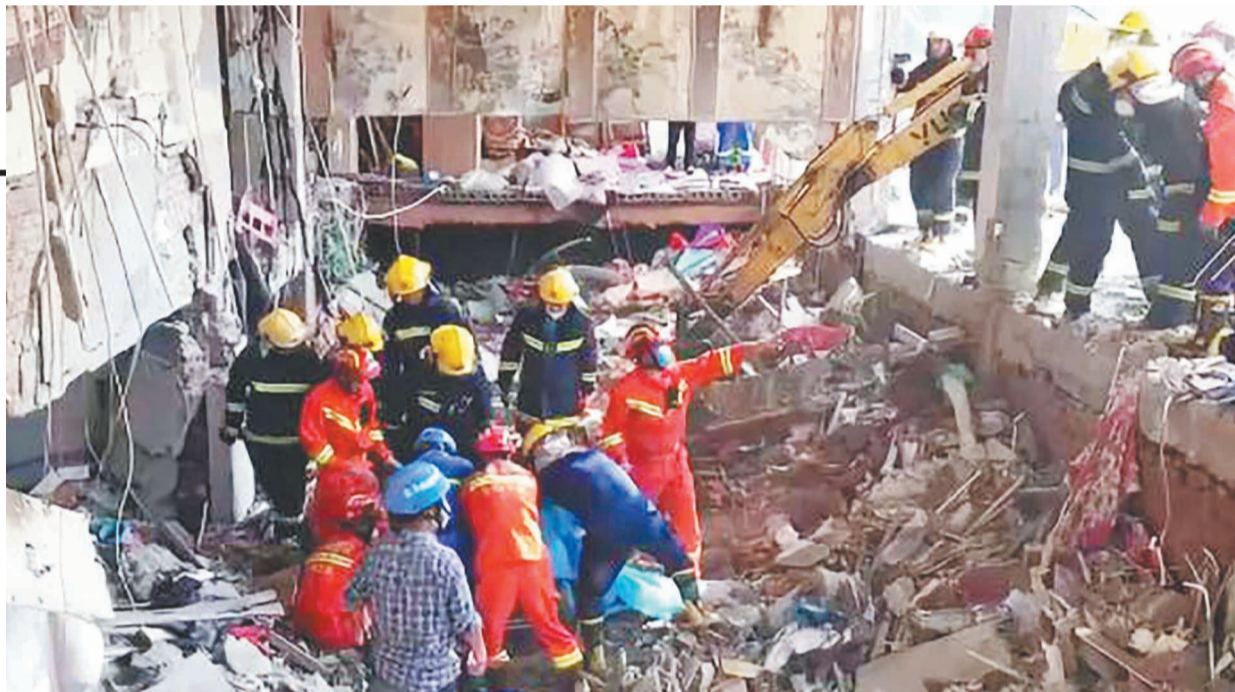
@江苏消防公布的一段搜救视频显示,爆炸现场被炸出一个大坑,有人员从废墟中被抬出。
