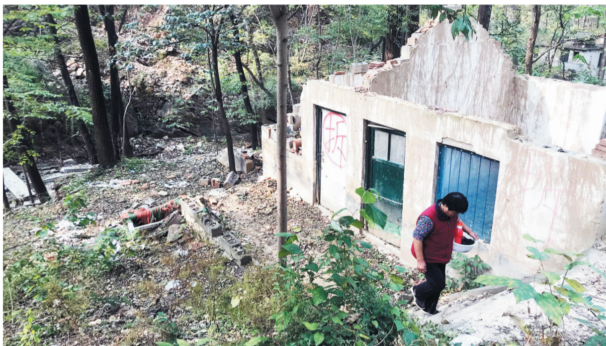
无序建设被拆除
