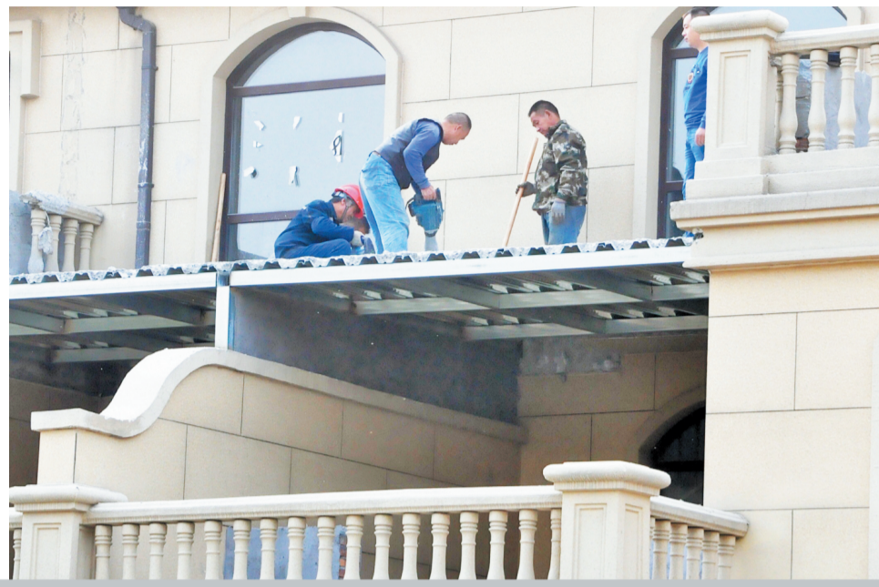
工作人员在国信国际公馆拆除违法建设。
