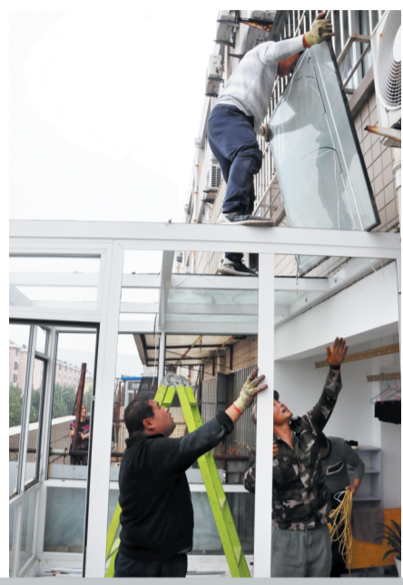
工作人员在颐和花园拆除违法建设的阳光房。
