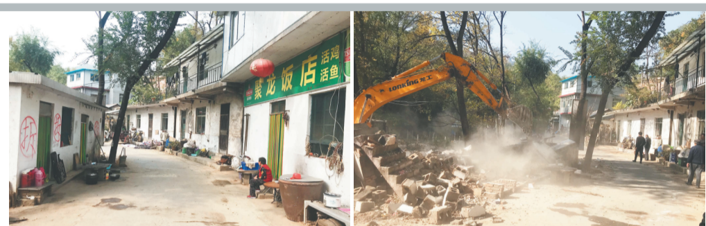
珍珠村沿河一处农家乐饭店的厨房被拆除前后。
