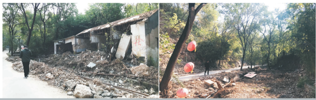
珍珠村沿河一处此前在台风中遭遇泥石流的农家乐饭店被拆除前后。
