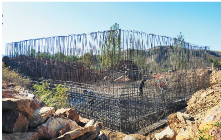
建设中的鹿角山蓄水池。
