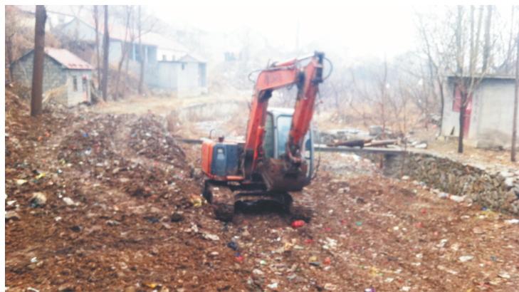
朱家户村修路、治理河道的建设场景。 资料照片
