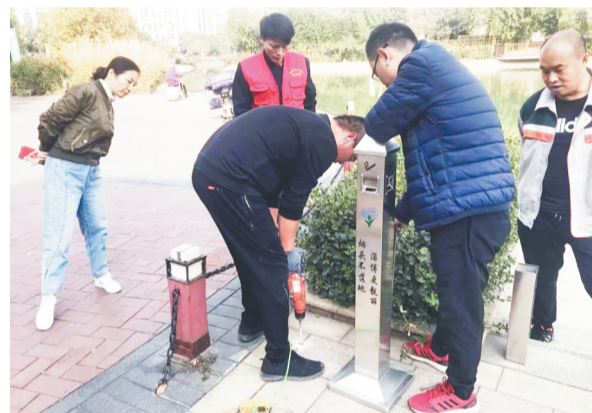
工作人员正在安装落地式烟灰缸。
