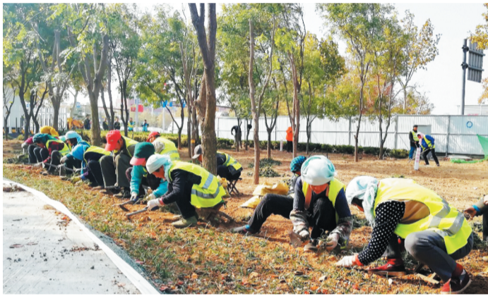
园林工人正在补栽植被。
