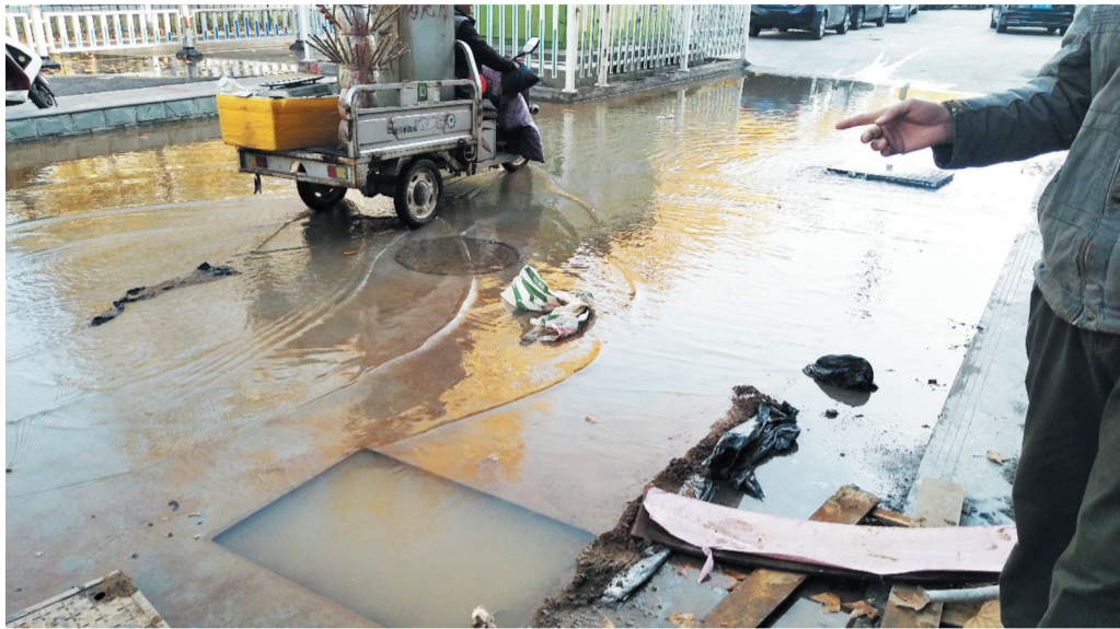
13日上午9点多,一辆三轮车正驶过沿街房前被淹没的路面。开着盖、灌满水的井是之前滴水的那个,另一侧一个窨井也在涌水。
