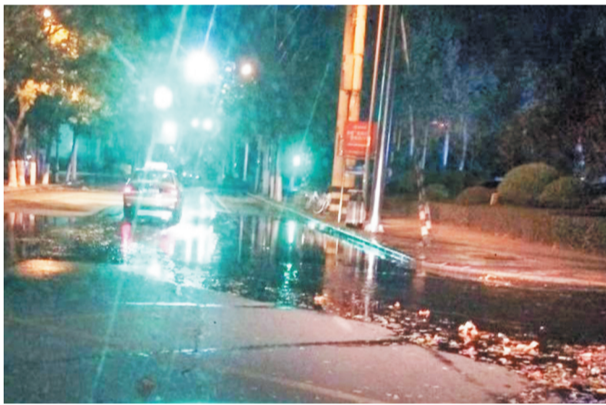
17日晚上9点50分,记者在现场看到,因管道破裂而漏出来的水已经流到了东二路。
