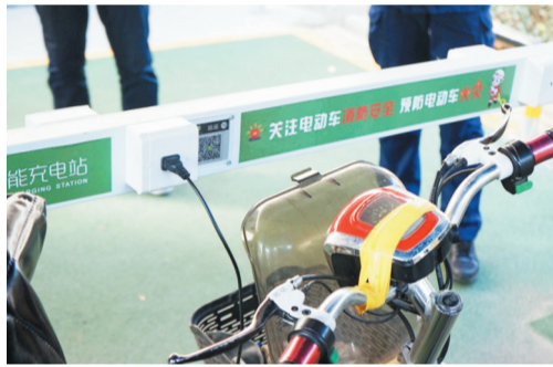
在傅家镇苏村泉山小区电动车集中充电棚内,居民在给电动车充电时会看到安全标语。
