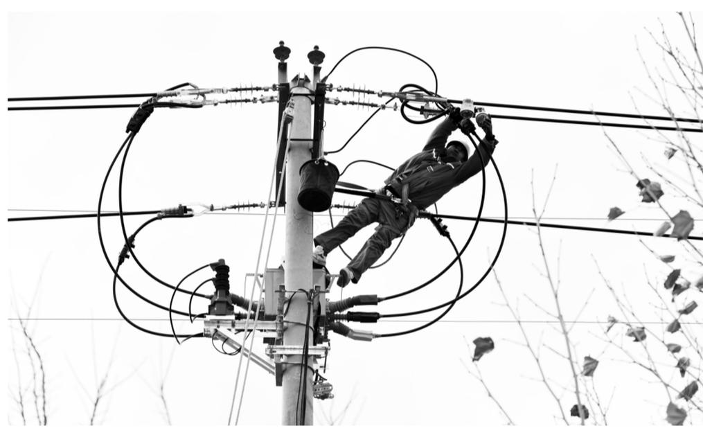
11月27日,山东淄博供电公司员工在齐鲁化学工业园区为10千伏边家线冯北支线1号杆安装分界开关。
