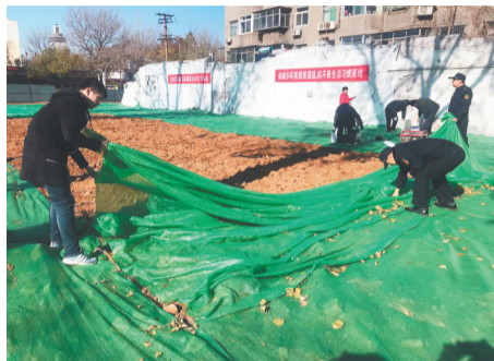
体育场街道办的工作人员正在用加密抑尘网覆盖大面积裸露的土地。
