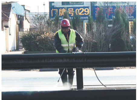
在马南路,工人正用洒水枪清理路中间护栏。
