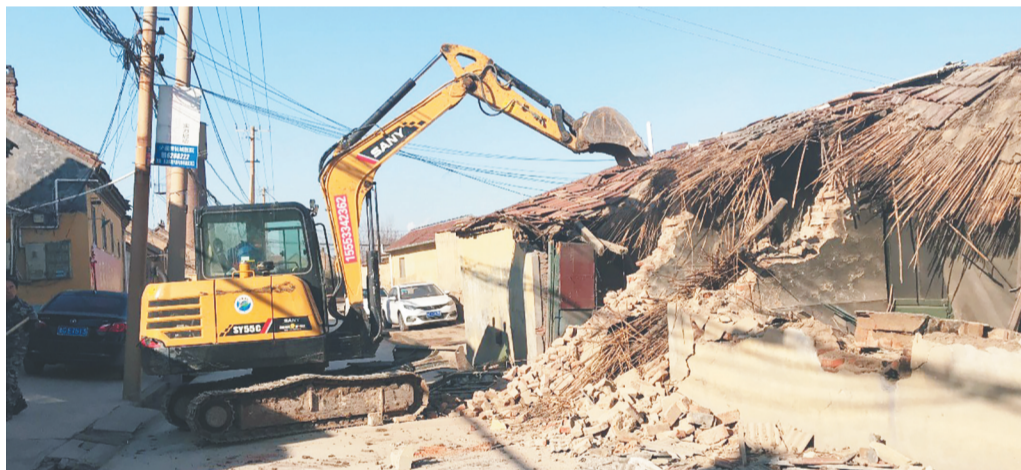
张店区黄家村正在拆除违章建筑,利用拆走后闲置的场地修建村民健身活动广场等。
