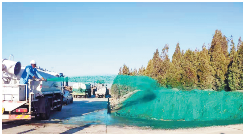
工作人员在牧龙山渣土消纳场喷洒扬尘抑制剂。
