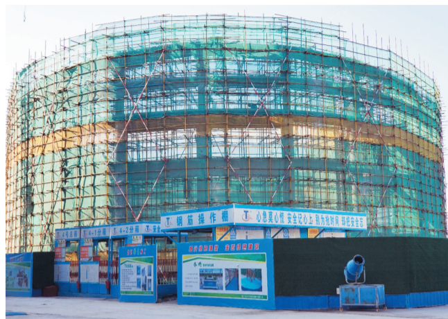
新区高中体育教学楼正在进行主体施工。
