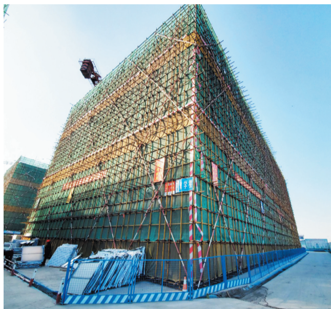
新区高中教学楼已经封顶，正在进行二次结构施工。
