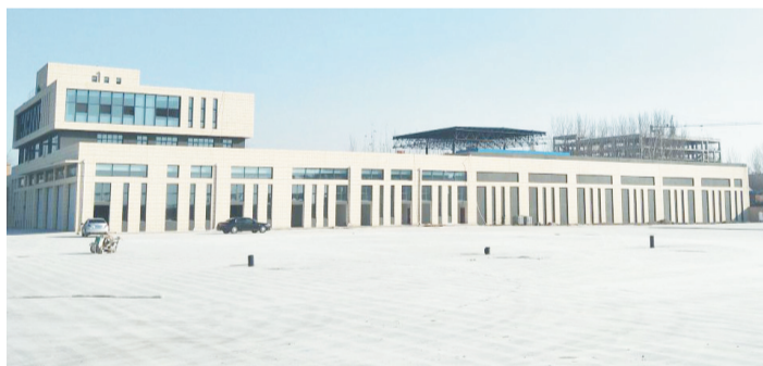
淄博高新区公交枢纽工程现场。
