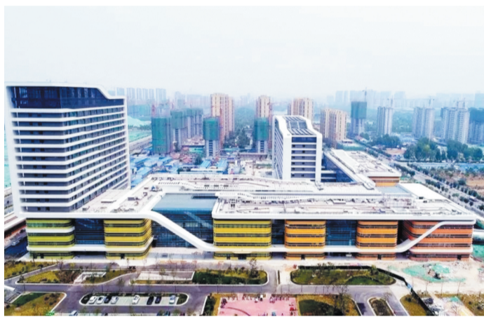
淄博市妇幼保健院新院区。
