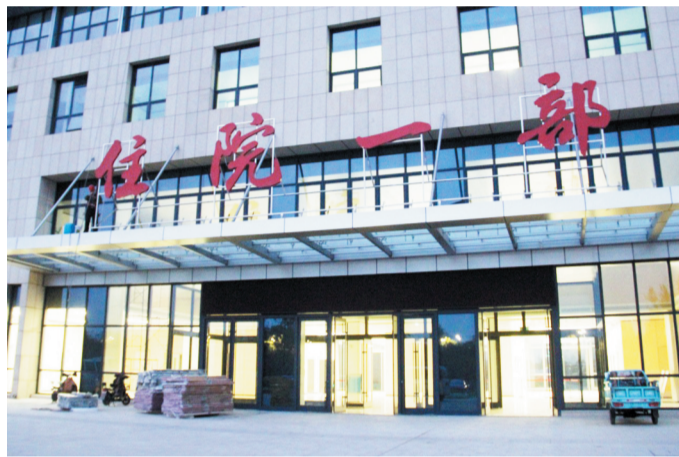
淄博市中心医院西院住院一部。
