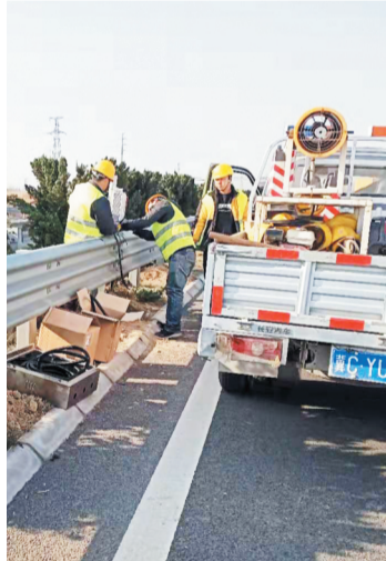
12月11日上午,工人在现场安装智能语音系统。
