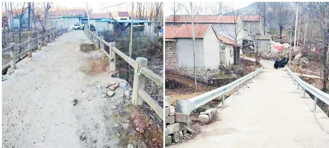
破烂不堪的桥(左图),经过修缮焕然一新(右图)。
