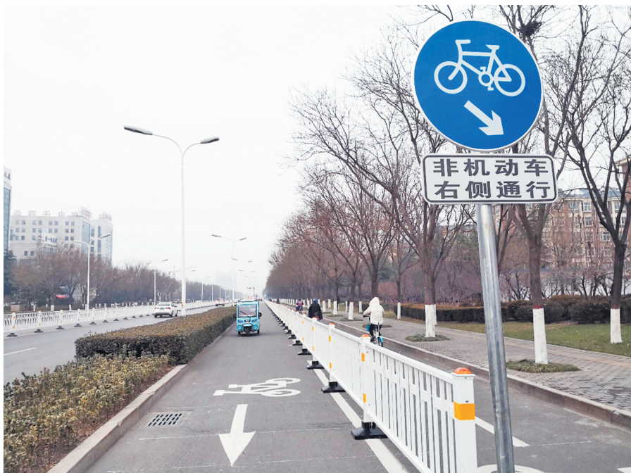
12月27日,柳泉路裕民路至金科学府段单侧双向非机动车道开始运行。
