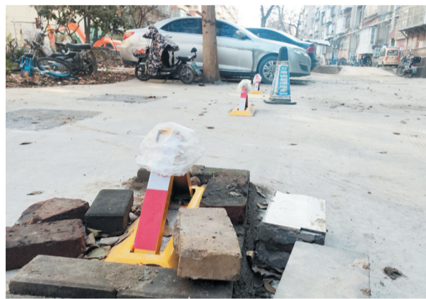
12月28日上午,记者在王舍铁路小区10号楼楼前看到,已经硬化好的路面上被人私自安装了地锁。
