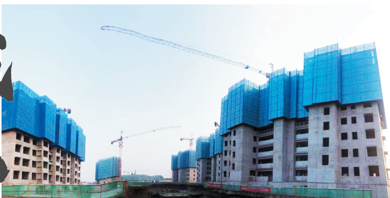
12月21日,火车站南广场改造片区安置工程快速推进。
