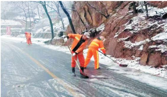
7日,博山区公路事业服务中心启动除雪防滑应急预案。应急队员统一上路,按照分工对每条省道进行巡查,并根据巡查情况采取机械与人工除雪相结合的方式连续作业,及时抛撒融雪剂和防滑料,确保干线公路安全畅通。
