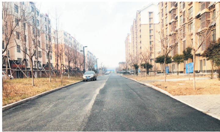
太平村为建设美丽乡村修建的沥青混凝土道路。
