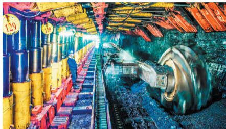
山东方大安装的煤矿大型综采工作面。
