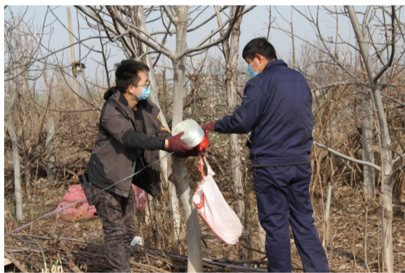
2月18日,施工人员在现场拉线测量,为设备进场施工做好准备。
