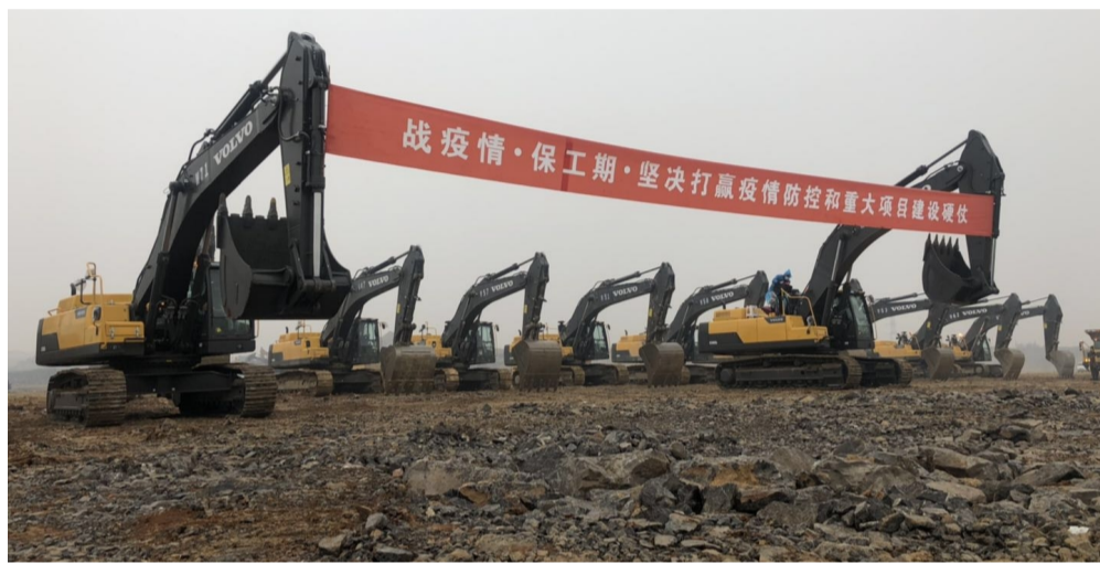
开工仪式现场。
