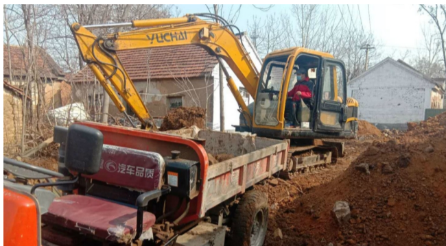
2月27日，工作人员用挖掘机清理村内道路。
