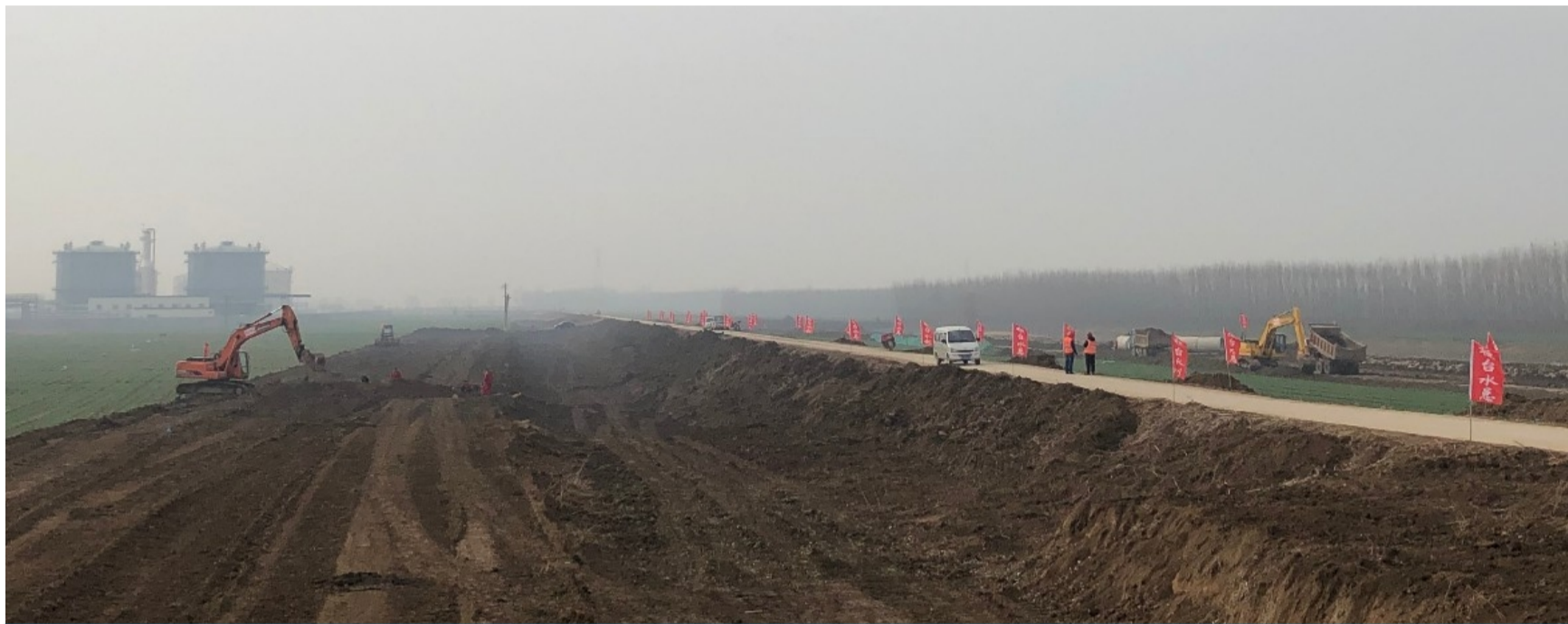
3月2日一早,小清河干流治理工程桓台县荆家段施工现场。
