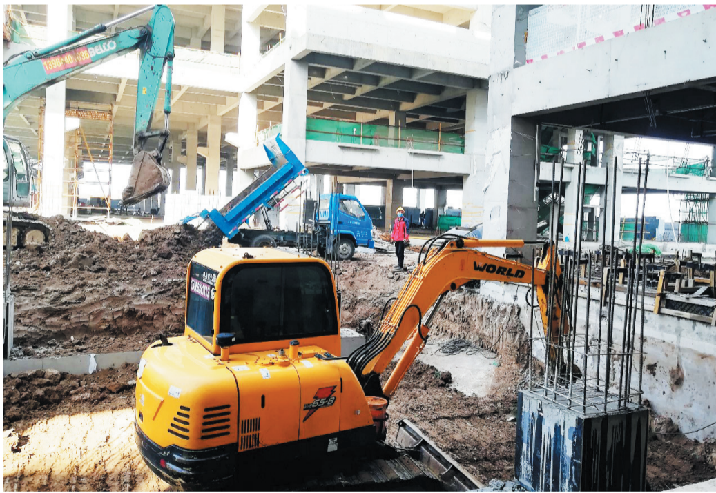
施工现场,陆续到位的施工人员正在抓紧赶工程进度。
