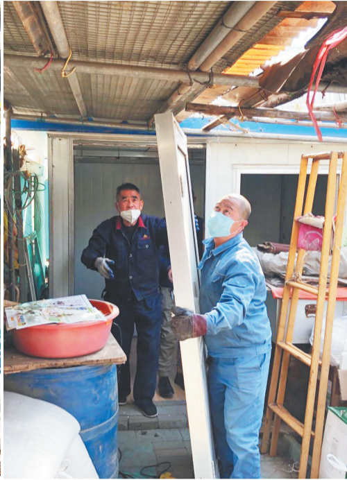
工人对违章建筑进行集中清理。
