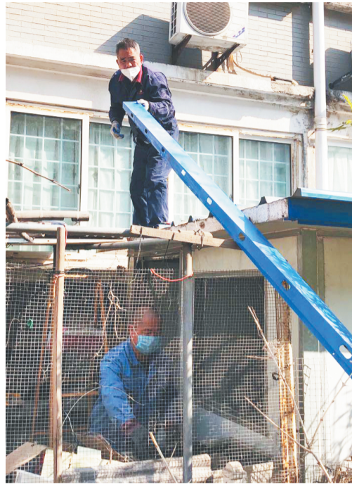
工人对私搭乱建进行了集中清理拆除。
