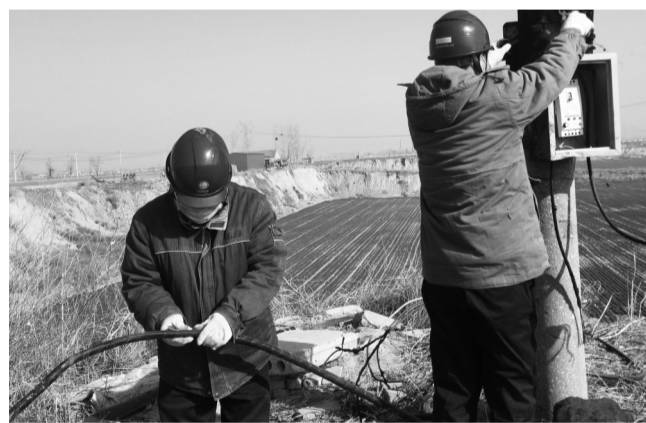
电力员工正在抢修线路。
