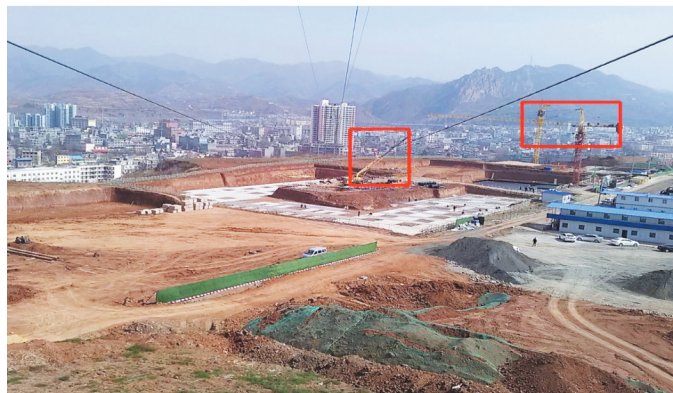
发现供电公司一基线路杆塔附近出现塔吊和吊车作业后,智洋创新的输电线路通道可视化平台将预警信息实时传达给客户。
