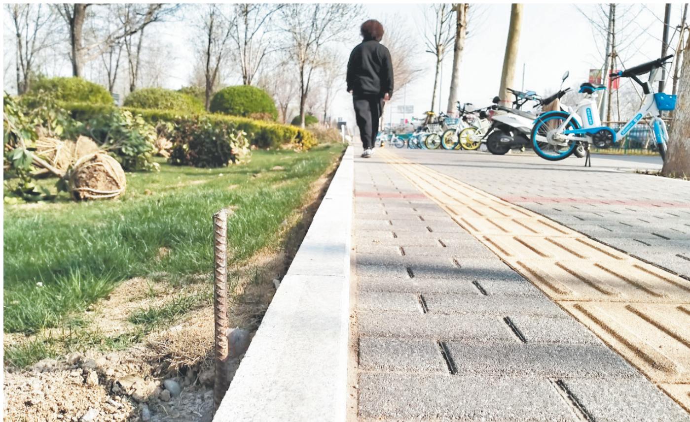
3月23日上午,在颐和大厦东侧,靠近路缘石的绿化带里竖着一根近20厘米高的钢筋。
