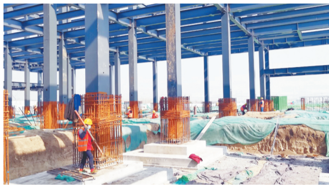
在高新区齐鲁新材料中试基地项目现场,工人正在加紧施工。
