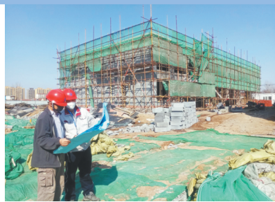
火热建设中的华星二期。宁涛 摄
