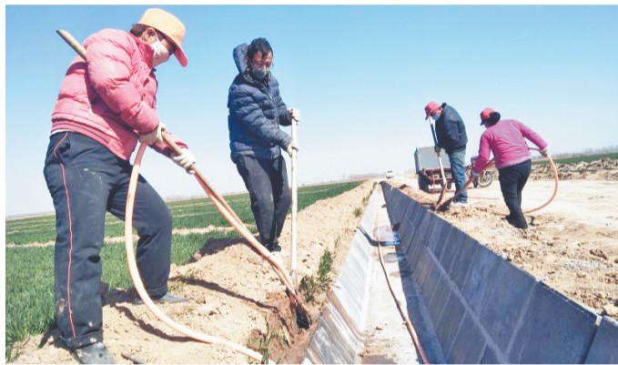
3月25日,在高青县木李镇北杜村的田间地头,施工人员正忙着做沟渠衬砌工程。
