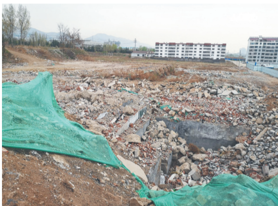
9:22 博山区人民路西首、博山区实验小学新校区在建项目西侧
