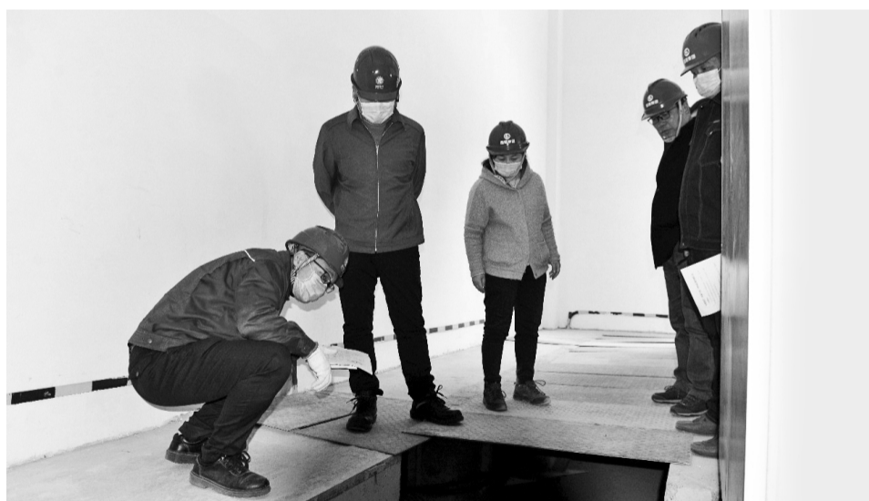
电力员工仔细检查土建工程用电项目。
