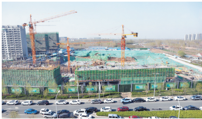
淄博经开区项目建设顺利推进。
