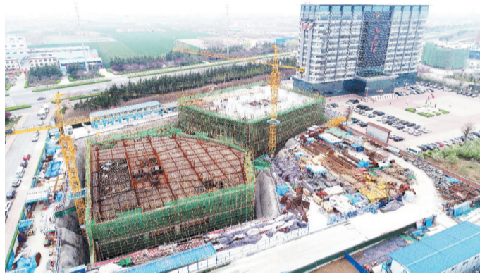
建设中的山东爱特云翔大数据产业园二期项目。
