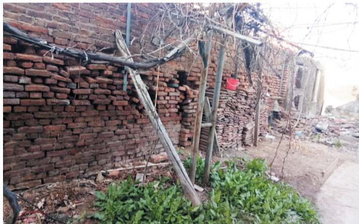
滨州华英小区的西围墙外面有围挡遮挡看不出问题,实际上墙体变形严重,需要木桩支撑。
