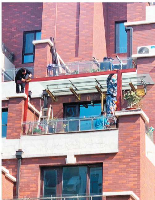
金域馨园拆违现场。
