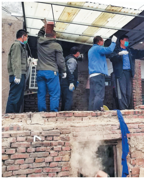
邀兔村一处违建正在拆除。
