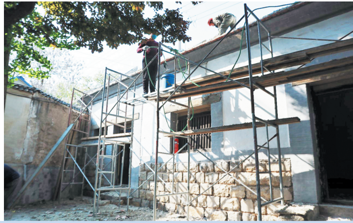
5月5日，博山镇刘家台村博山县委旧址正在修复。
