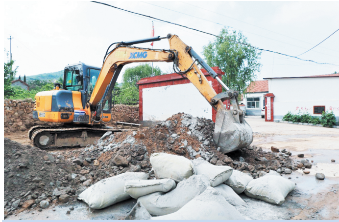
5月5日，博山镇上结村村委门前的小广场正在进行施工。
