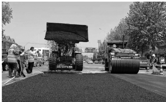
养护工人对路面实施坑槽挖补作业。
