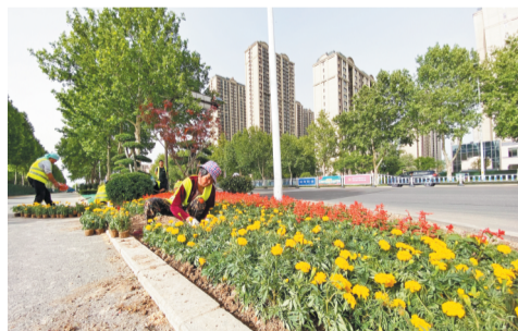
5月12日,北京路齐盛宾馆门前,绿化施工人员正在进行植物景观塑造。
