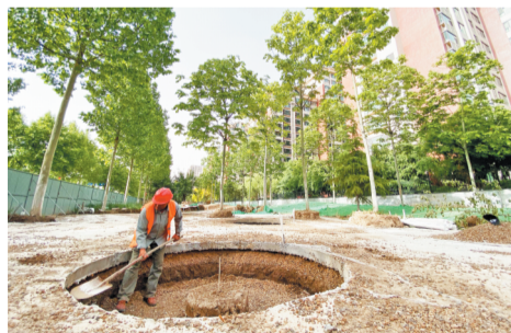
5月12日,北京路上一处将建为带状公园的施工现场。
